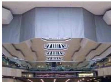
**Противопожарный занавес (пожарный занавес, противопожарный экран, «железный занавес») —** огнеупорная дымонепроницаемая конструкция с нормируемым пределом огнестойкости, выполненная из негорючих материалов (металл, железобетон, огнеупорная ткань) и опускаемая при пожаре для отделения сцены от зрительного зала. Служит для предотвращения распространения пожара и продуктов горения в течение нормируемого времени.
